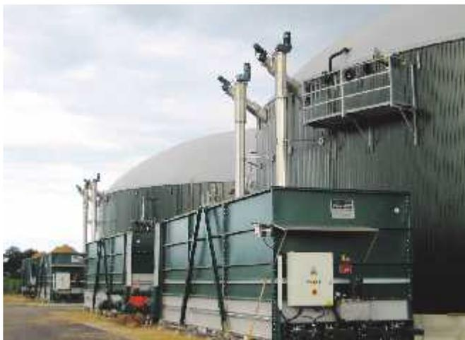
Für das Feststoffhandling werden 75 m<sup>3</sup>-Feststoffdosierer mit Schubboden sowie Schneckeneintrag eingesetzt.
