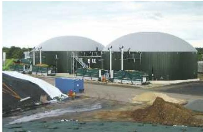
Die Fermenter haben ein Nettovolumen von je 4.900 m<sup>3</sup> und wurden aus Stahlbeton gefertigt.
